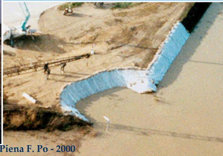
Nel caso in cui si notino sul fianco arginale interno dei cedimenti, preludio ad un possibile indebolimento dell'argine stesso, è previsto il varo del telone per proteggere le zone dell'argine più esposte all'azione erosiva delle acque.
