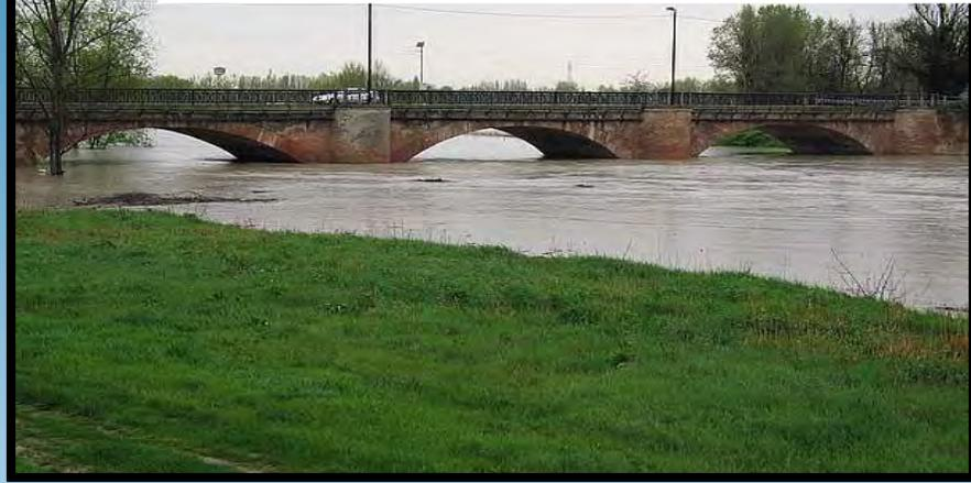
2007-Modena (V. Gherbella): ostruzione delle luci del ponte sul T. Tiepido
